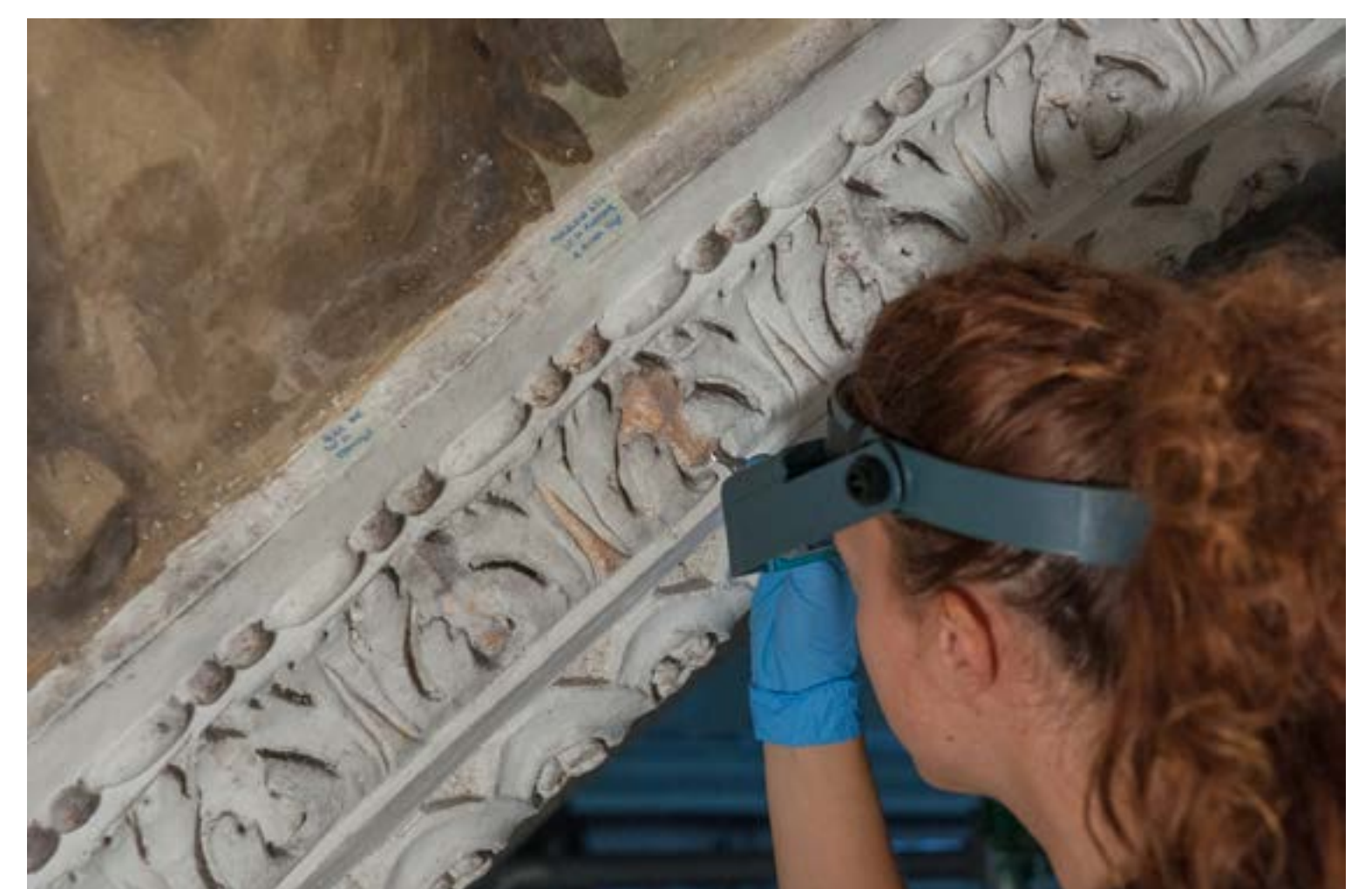
Fig.5 : Durante la pulitura delle cornici in stucco, 2018.
