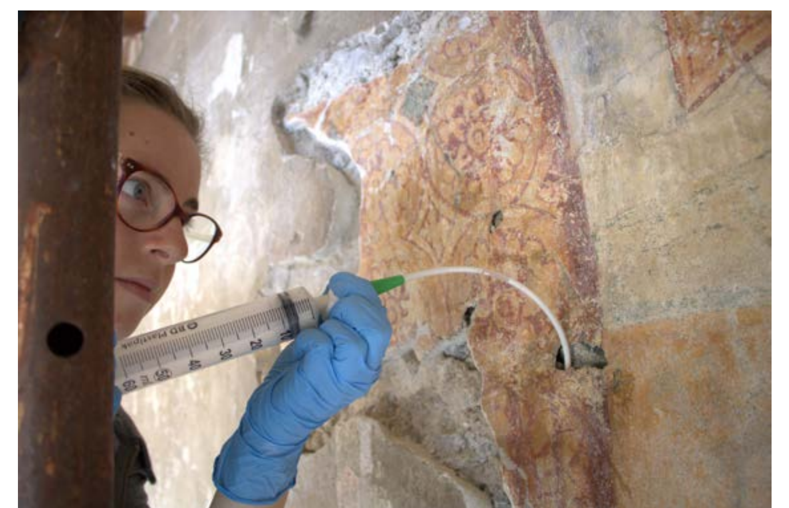
Fig.4 : Campata 8. Consolidamento degli intonaci distaccati con iniezioni di malta idraulica premiscelata, 2018.
