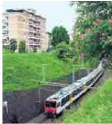
La "trincea" di Massagno
