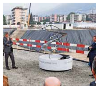
SI COMINCIA Quale simbolica prima pietra del cantiere, è stata scelta una fontana che ha la forma di doppia elica di DNA. (Foto Crinari)
