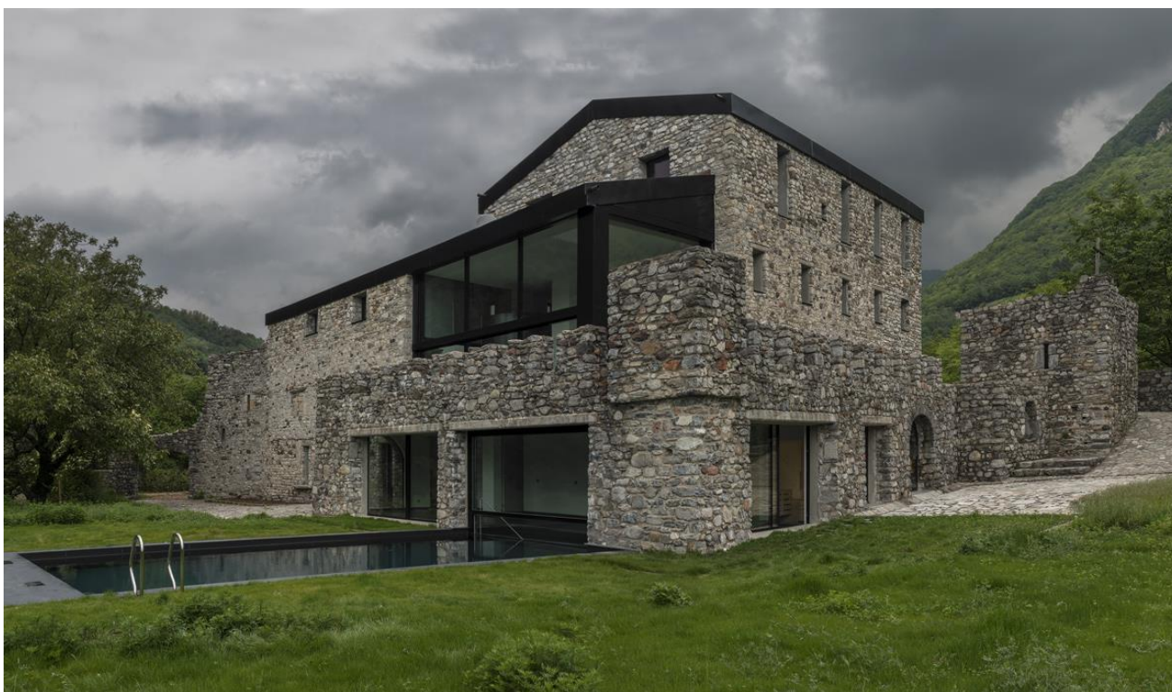
Castello di Doragno a Rovio: un edificio antico a consumo zero. Foto: © Deltazero SA
